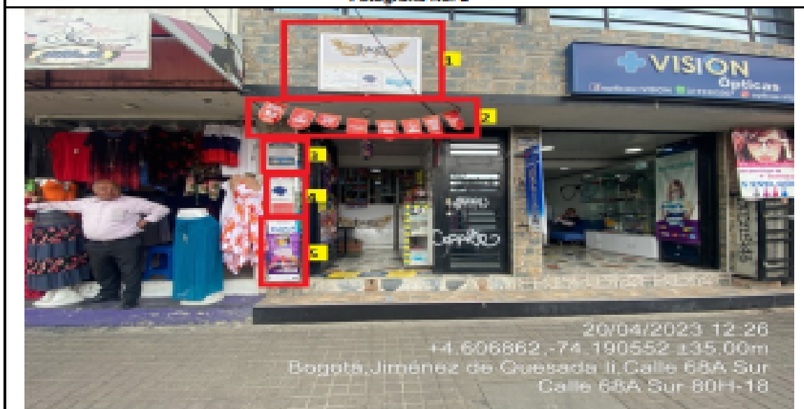
En la cual se evidencia la fachada del establecimiento comercial L & G VARIADADES, en la que se observa: un (1) elemento publicitario tipo aviso en fachada identificado con el número 1, el cual al momento de la visita técnica se encontraba instalado sin contar con el registro ante la SDA, así mismo, un (01) elemento publicitario identificado con el número 2 el cual está volado de la fachada del establecimiento, y tres (3) elementos publicitarios identificados con los números 3, 4, y 5 los cuales son adicionales al único permitido.
